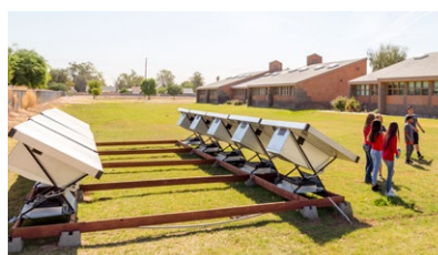
El agua que finalmente se canaliza desde los hidropaneles, una vez tratada, es potable y tiene buen sabor.
